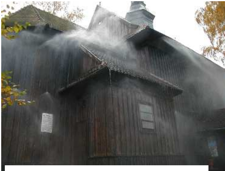
Wassernebellöschanlage an einer Holzkirche (Quelle: www.supo-com.pl )
