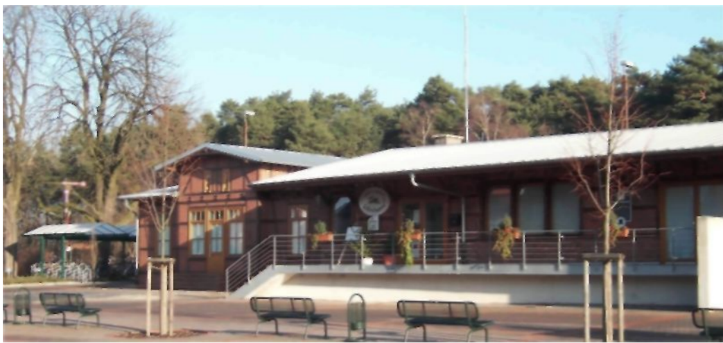
Bahnhofumbau Schloß Holte-Stuckenbrock
