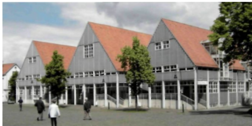
Stadtbücherei in Wiedenbrück
