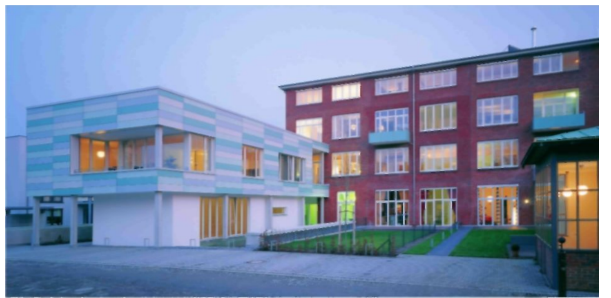
Bebauung Bartelsgelände Gütersloh
