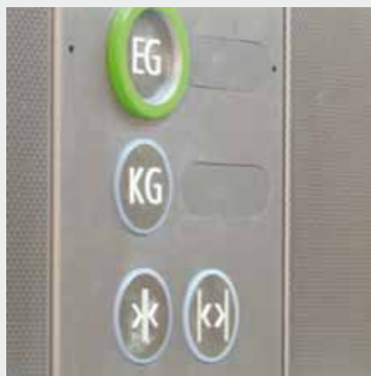
Diese Tasten, darunter die Erdgeschoss-taste (Gebäudeausgang), sind für blinde Menschen gut tastbar
