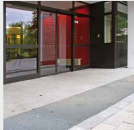
Ein feinmaschiges Drainage-Gitter vor dem Eingang ist auch für Personen im Rollstuhl oder mit Gehbehinderung geeignet
