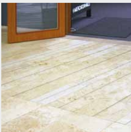
In die Bodenplatten eingefräste Rillen bilden ein taktiles, jedoch nicht kontrastreiches Aufmerksamkeitsfeld vor einem Saaleingang
