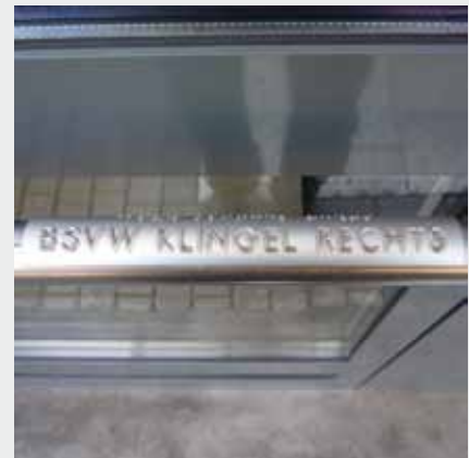
Auf dem horizontalen Türgriff wird in erhabener Profilschrift und Brailleschrift auf die Klingel hingewiesen
