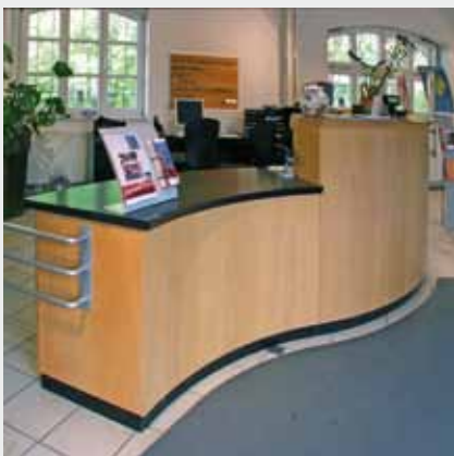
Der Empfangstresen ist teilweise abge-senkt, aber nicht unterfahrbar
