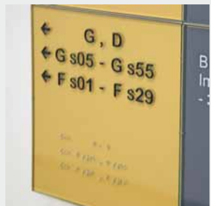
Kontrastreiches Schild mit Hinweisen auf Gebäudeteile und Raumnummern in erhabener Profilschrift und Brailleschrift
