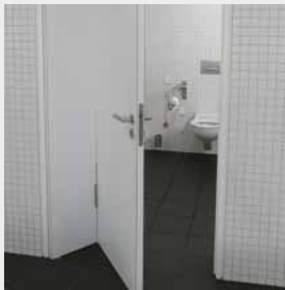
Eine Raumpartür kann vom Rollstuhl aus ohne zusätzliche Fahrmanöver betätigt werden
