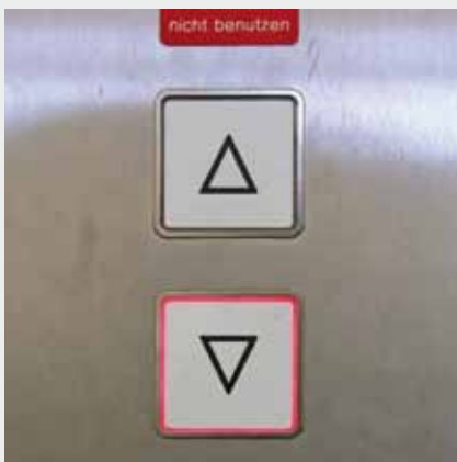
Bei Betätigung leuchten die Druckpunkt-tasten auf; sie werden im Gegensatz zu Sensortasten jedoch nicht schon beim Abtasten ausgelöst
