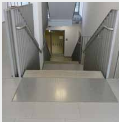
Insbesondere am oberen Treppenende verhindert das Aufmerksamkeitsfeld gefährliche Stürze
