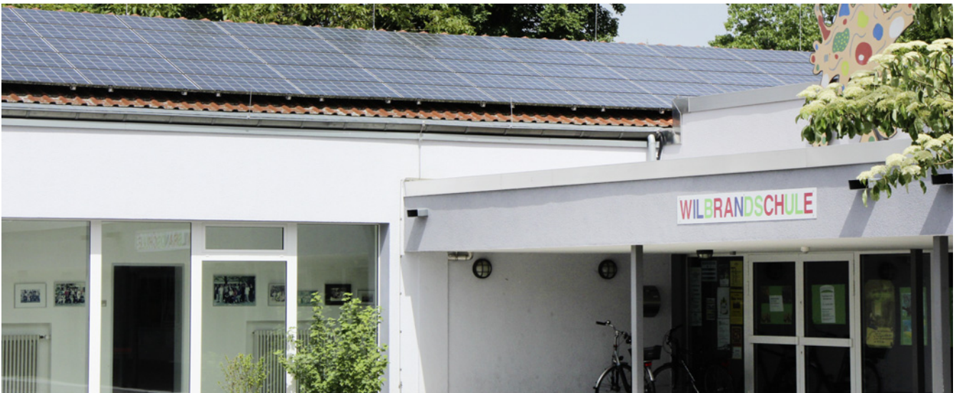
Photovoltaikanlage auf dem Dach der Wilbrandschule Clarholz (K. Wellmann)
