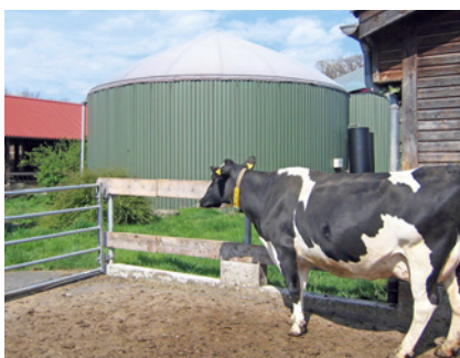
Biogasanlage (K. Ortmeier)
