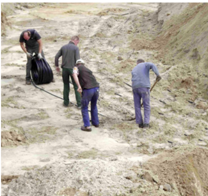
Bei dem Einbau eines Erdwärmekollektors werden Schläuche ca. 1,5 m tief im Boden verlegt und dann wieder zugeschüttet (N. Brandstetter)
