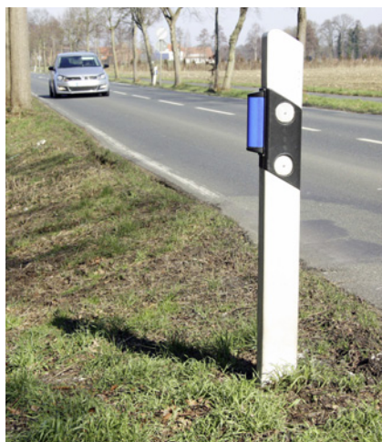
Das Scheinwerferlicht der Fahrzeuge wird in den blauen Reflektoren an den Pfählen der Straßenbegrenzung reflektiert und warnt das Wild vor dem Überqueren der Straßen vor herannahenden Fahrzeugen (D. Schönknecht)
