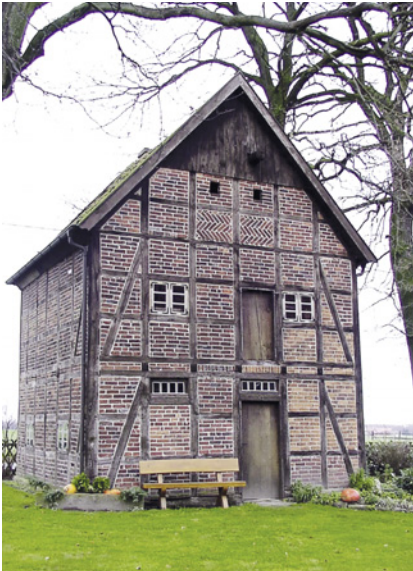
Ein alter Speicher in der Gemeinde Langenberg. In diesem Lagerhaus wurde das Getreide der Dorfgemeinschaft aufbewahrt und getrocknet (W. Wieneke)
