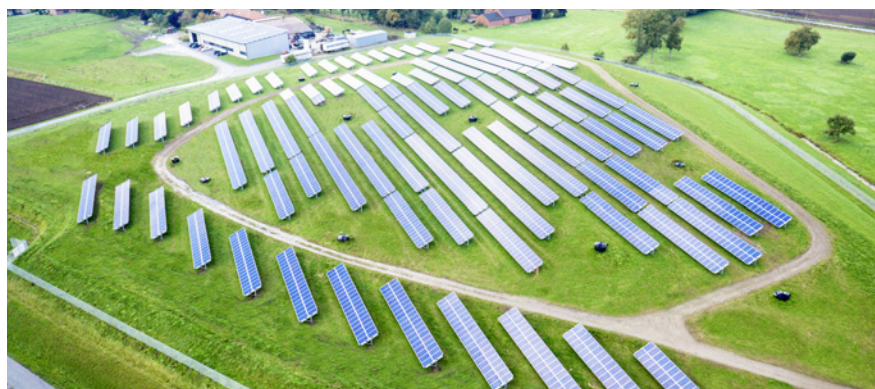
Auf der ehemaligen Hausmülldeponie in Rietberg wird jetzt umweltfreundlicher Strom gewonnen (P. Smiatek für die GEG)
