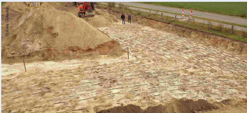
Verlegung eines geothermischen Flachkollektors zur Erdwärmenutzung in Lintel.
