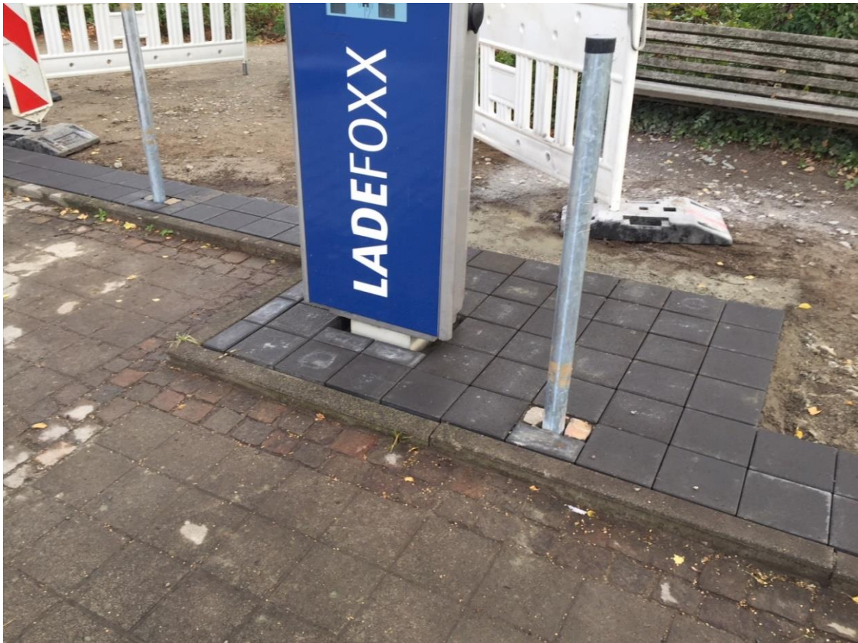
Impr. 3: Pflasterung der Ladesäule mit Metallpfosten zur Stellplatzbegrenzung
