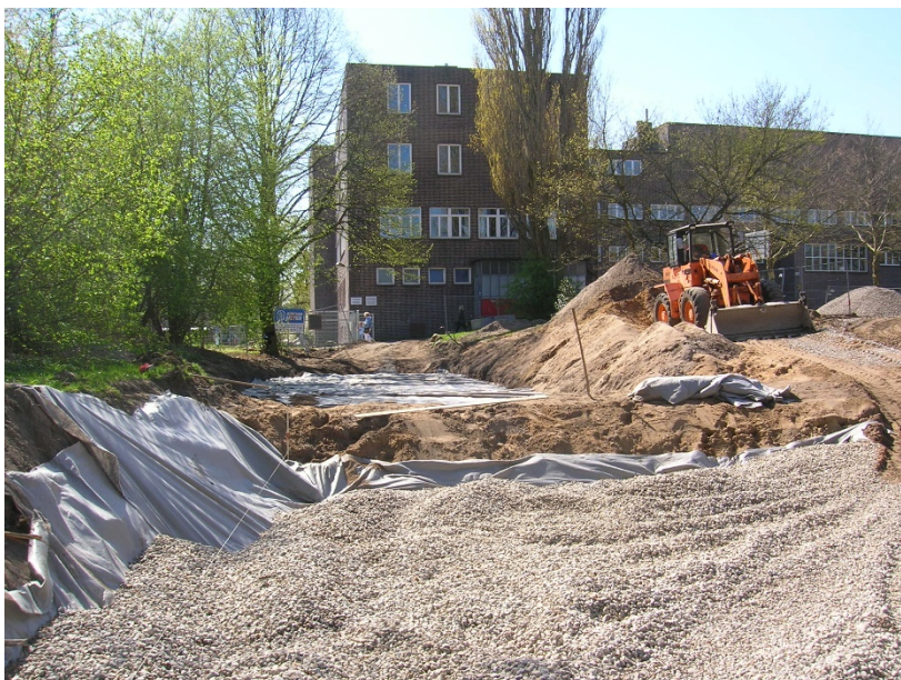
Abbildung 76: Einbringen von Füllkörperrigolen auf einer Sauberkeitsschicht
