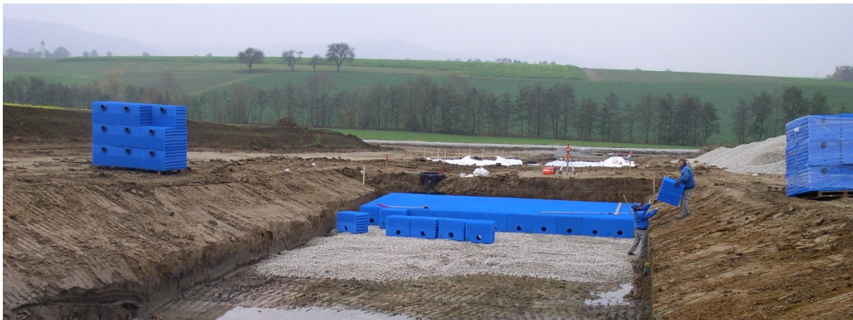
Abbildung 76: Einbringen von Füllkörperrigolen auf einer Sauberkeitsschicht
