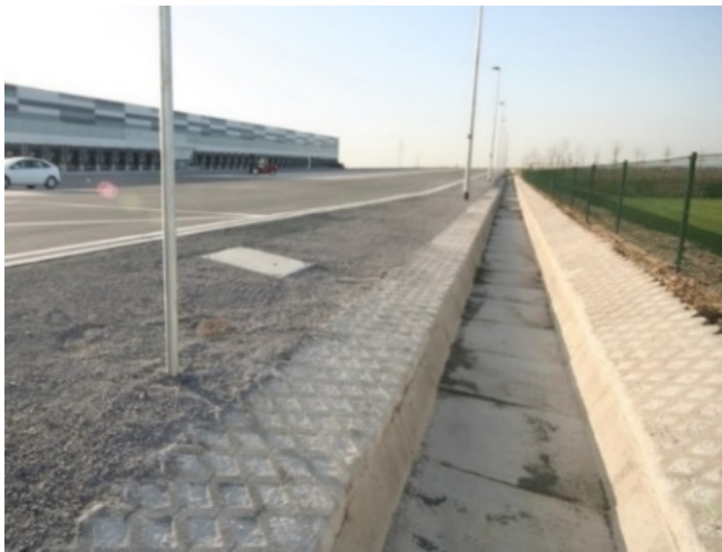
Abbildungen 36 & 37: Offener Graben als Kastenform (links). Verengung des Fließquerschnitts durch Sedimente und Grasaufwuchs (rechts)
