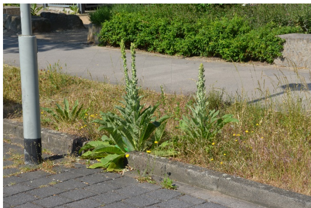
Abbildungen 53 & 54: Verkrautung punktueller Zuläufe (links) und aufgrund fehlender Abschlusssteine (rechts)
