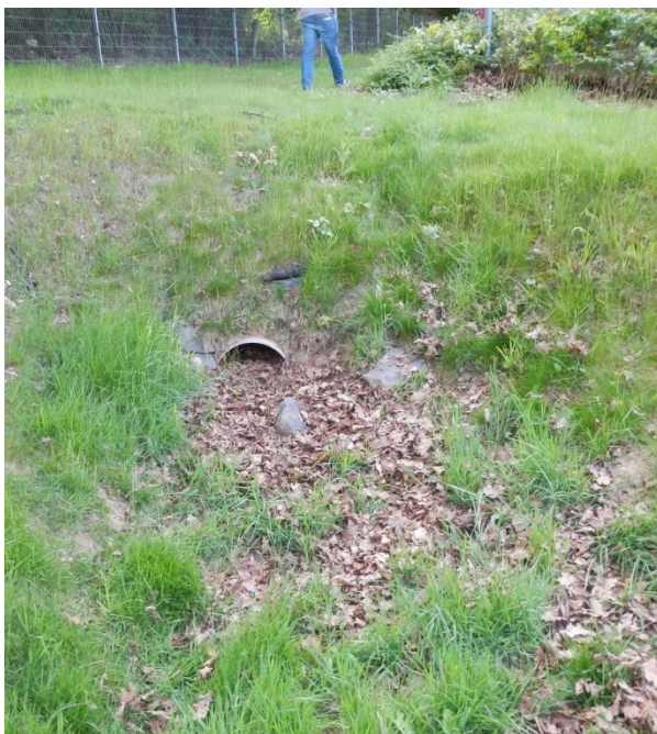
Abbildungen 61 & 62: Funktionsverlust einer Zuleitung durch fehlenden Höhensprung und mangelhafte Unterhaltung (links); freier Rohrauslass mit Kolktschutz und Höhensprung (rechts)
