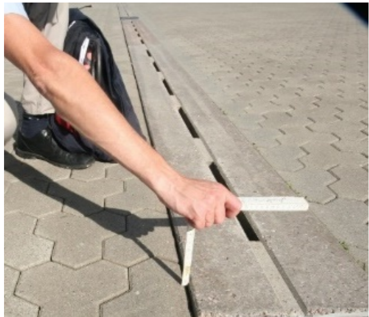
Abbildungen 34 & 35: Verkrautung einer Schlitzrinne bei unsachgemäßer Pflege des Auslaufbereichs (links) und Absenkung der angrenzenden Flächen mit Verlust der Entwässerungsfunktion und Gefahr der Pfützenbildung (rechts)
