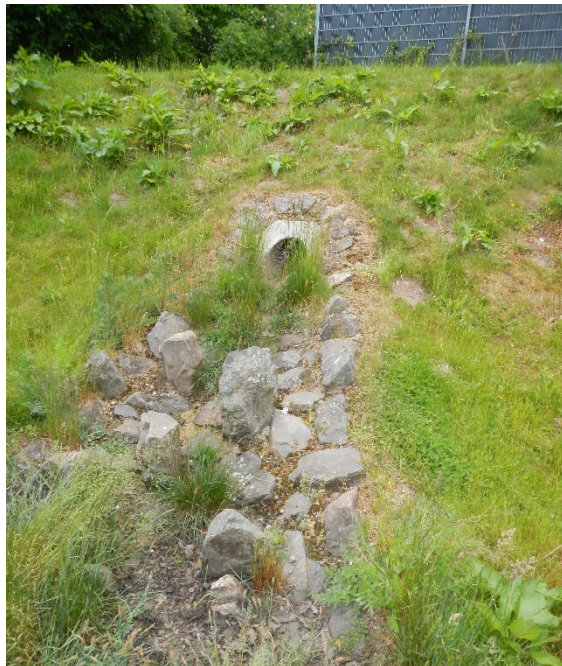
Abbildungen 61 & 62: Funktionsverlust einer Zuleitung durch fehlenden Höhensprung und mangelhafte Unterhaltung (links); freier Rohrauslass mit Kolktschutz und Höhensprung (rechts)
