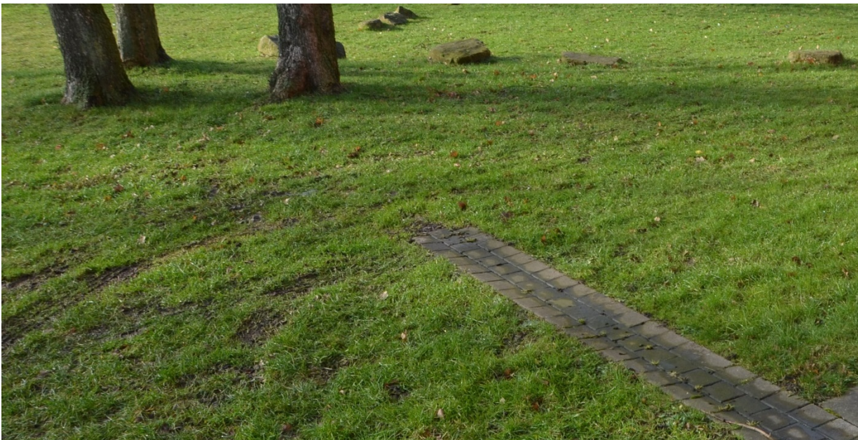
Abbildung 64: Das Befahren der Sickersohle mit schwerem Gerät (z. B. Mäher) kann im erdfeuchten Zustand zu irreversibler Verdichtung führen
