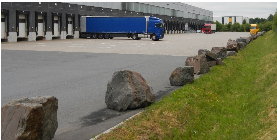
Abbildung 38: Offener Graben mit durchgehendem Fließgefälle, Befahrungsschutz und ordnungsgemäßer Pflege der Grasnarbe in Sohle und Böschung
