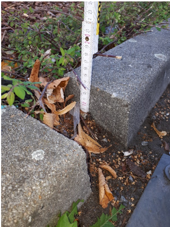
Abbildungen 50 & 51: Versagen der Ableitungsfunktion durch Ablagerungen in der Hochbordlücke (links); funktionsfähiger Einlauf durch Abschlussstein zwischen dem Hochbord (rechts)
