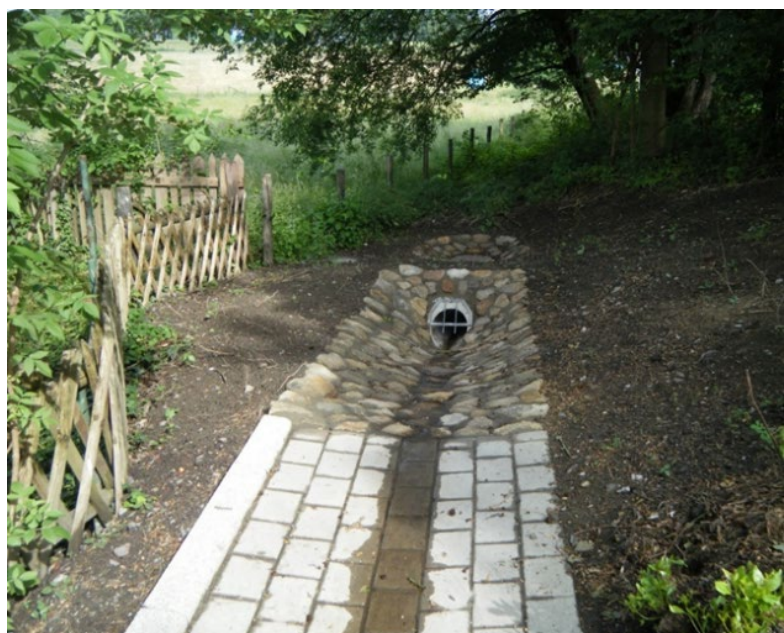
Abbildungen 41 & 42: Rinne im Straßennebenraum mit massiven Ablagerungen von Laub und Sediment (links) und ordnungsgemäße Rinne im Straßennebenraum mit Übergang zu Verrohrung (rechts)
