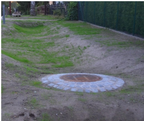
Abbildungen 79 & 80: Notüberläufe mit ordnungsgemäßem Abstand zur Muldensohle. Ausführung als Gitterrost (links) und als Überlaufrohr mit Tauchwandaufsatz (rechts)
