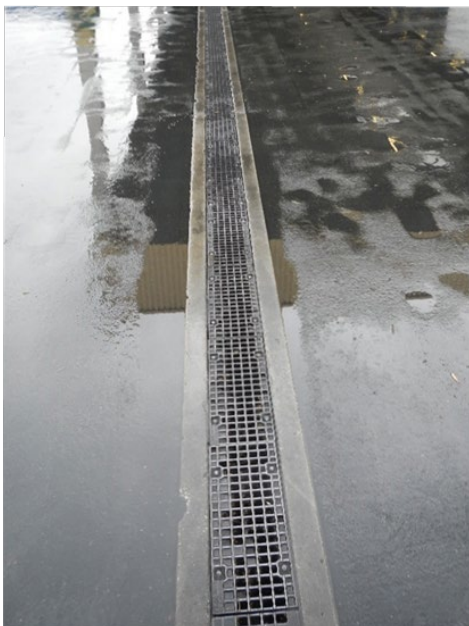
Abbildung 33: Typische Kastenrinne in Betriebsfläche. Setzungen des Fahrbahnbe-lags gegenüber Einfassung führen zu Pfützenbildung
