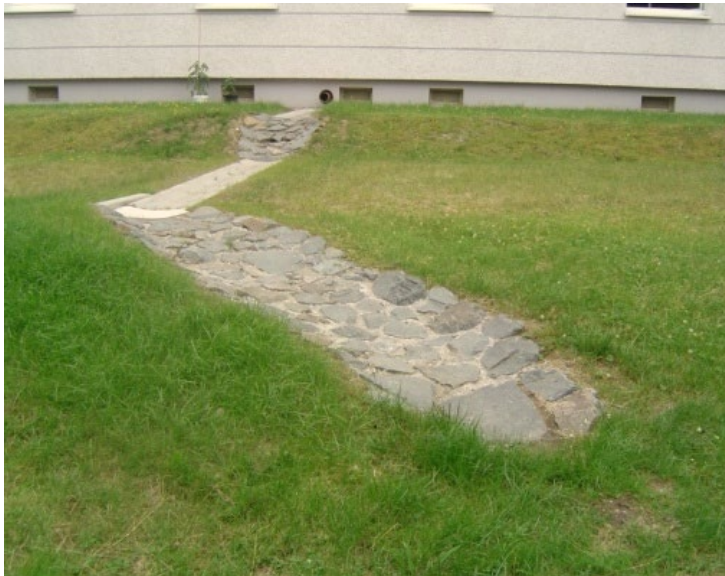
Abbildungen 56 & 57: Große Zulaufrinne mit rauen Wasserbausteinen in Gefällebereichen und glatten Muldensteinen in flachen Bereichen (links); breitflächige Zuleitung mit erfolgreich unterbundener Erosion durch Strömungsstörsteine (rechts)
