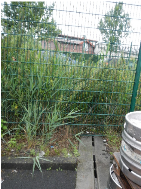
Abbildungen 34 & 35: Verkrautung einer Schlitzrinne bei unsachgemäßer Pflege des Auslaufbereichs (links) und Absenkung der angrenzenden Flächen mit Verlust der Entwässerungsfunktion und Gefahr der Pfützenbildung (rechts)
