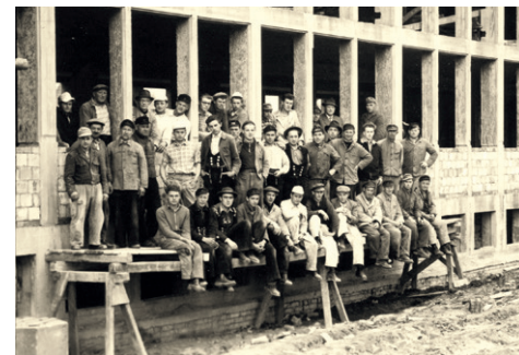
← Bauarbeiter am Rohbau des Kreishauses Wiedenbrück, ca. 1956. (Kreisarchiv Gütersloh A 03b/05-630; Foto: Etscheidt)
