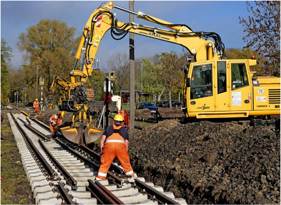
Gleisbaumaßnahmen der LWG Lappwaldbahn Gleisbau GmbH am 4. November 2020 im Bahnhof Bad Laer.
