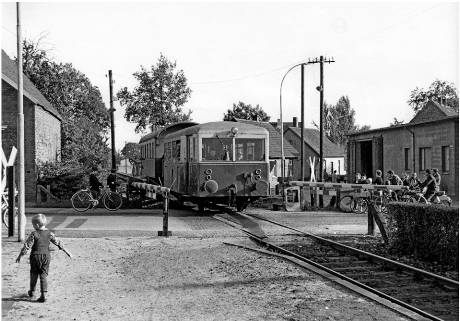
Einfahrt des Triebwagens VT 31 aus Gütersloh in den Bahnhof Versmold über die Münsterstraße im August 1964. Zur Vergrößerung der Sitzplatzkapazitäten wird ein Personenwagen mitgeführt. Aufnahme Eckehard Frenz, Sammlung Josef Högemann
