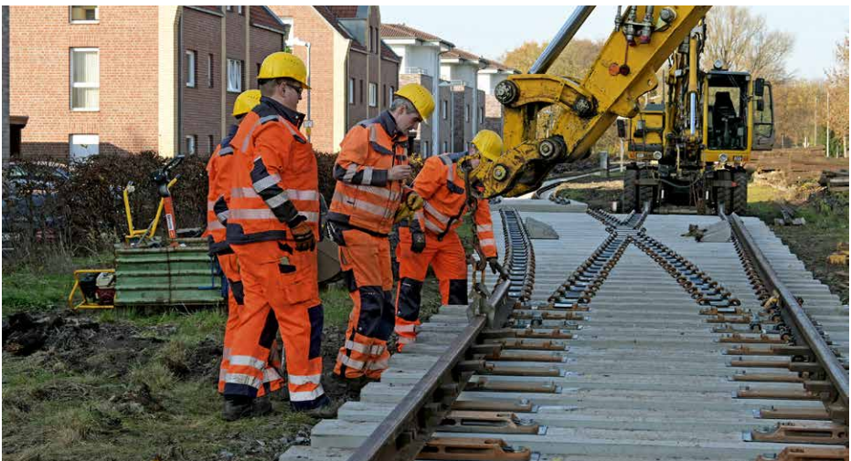
Der Einbau einer modernen Weiche mit Betonschwellen erfordert eine Menge Fachkenntnis (Bahnhof Bad Laer, 25. November 2020).
