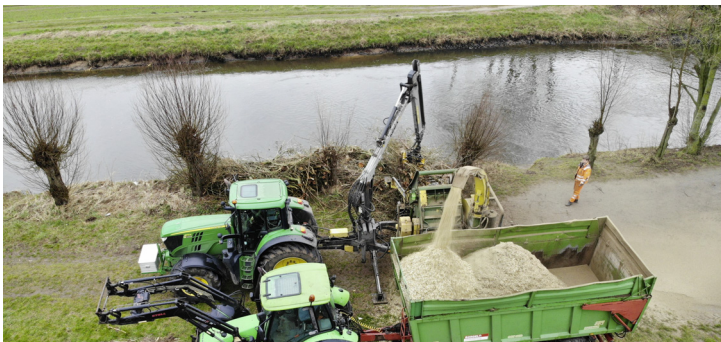
Arbeiten an der Ems in Harsewinkel: Der Greifarm am Traktor-Anhänger befördert die Weidenäste in den Häcksler, der das Holz zu kleinen Spänen verarbeitet. Foto: Isabelle Gruschke/Kreis Gütersloh
