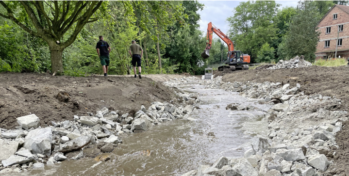
Die Dalke bei Ruthmanns Mühle in Gütersloh wurde renaturiert. Foto: Lena Baron / Kreis Gütersloh
